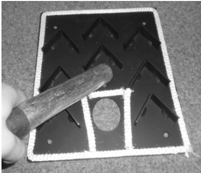
Figura 130 - Limpeza do circuito de fumos
